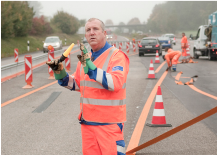
BAUSTELLENEINRICHTUNG UNTER BETRIEB, © ASTRA
