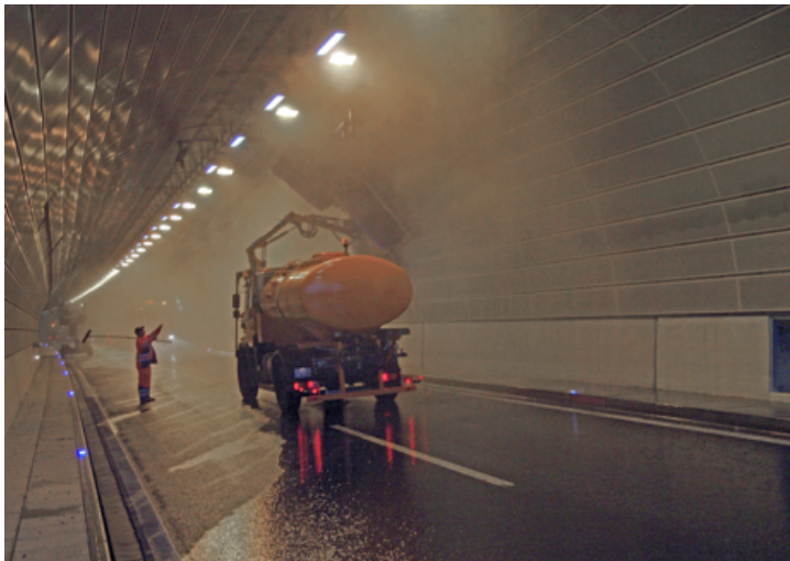
TUNNELREINIGUNG MIT SPEZIALFAHRZEUG
