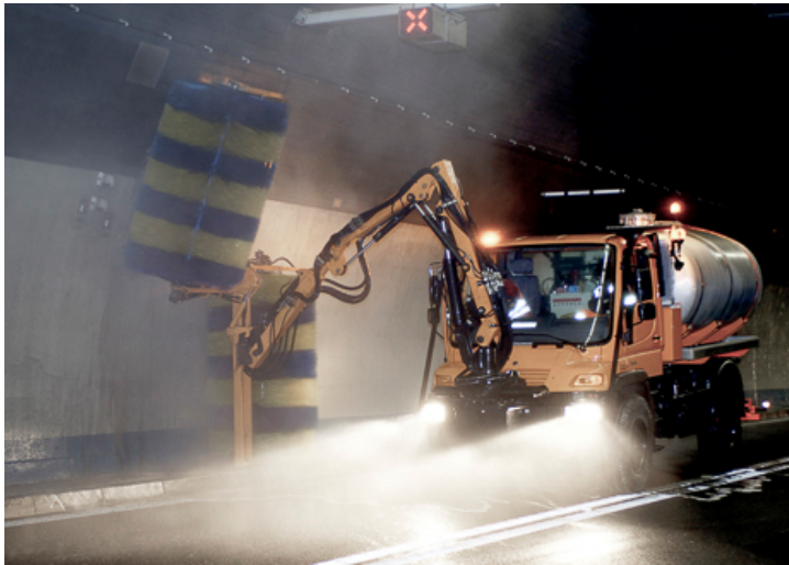
TUNNELREINIGUNG MIT SPEZIALFAHRZEUG
