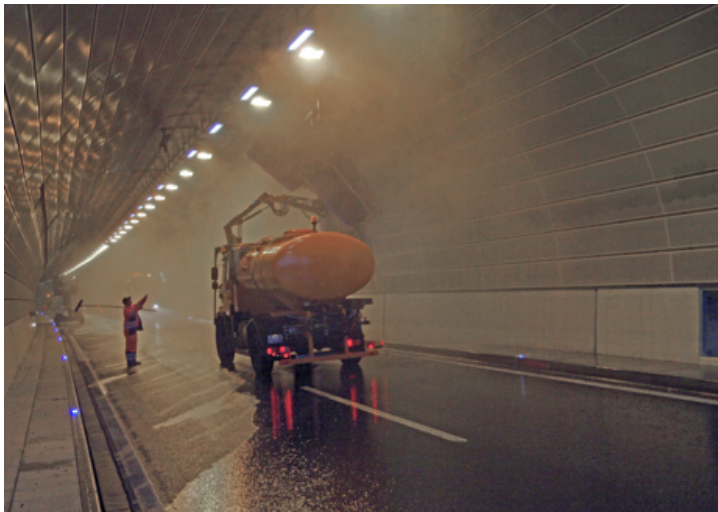
TUNNELREINIGUNG MIT SPEZIALFAHRZEUG
