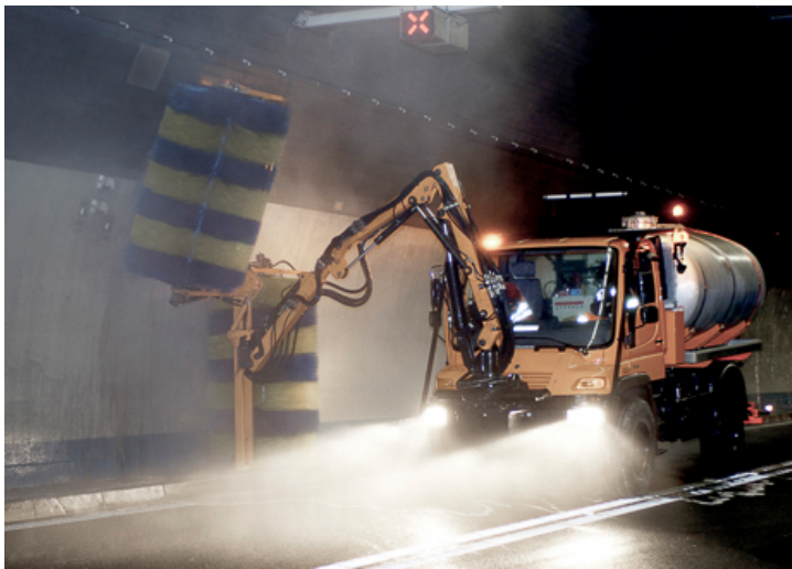
TUNNELREINIGUNG MIT SPEZIALFAHRZEUG
