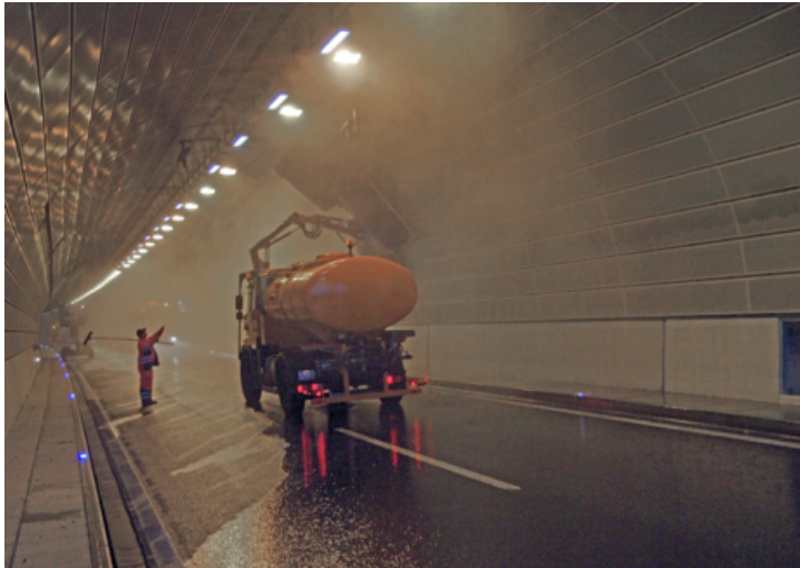
TUNNELREINIGUNG MIT SPEZIALFAHRZEUG
