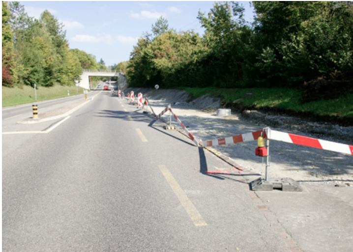
RAD- UND GEHWEGBAU KANTONSSTRASSE
