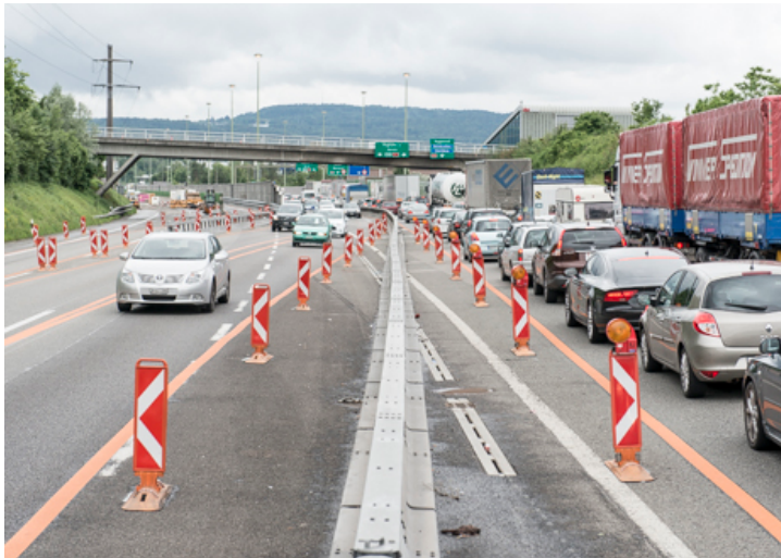
ÜBERLEITUNG AUF GEGENFAHRBAHN MIT SPURREDUKTION
