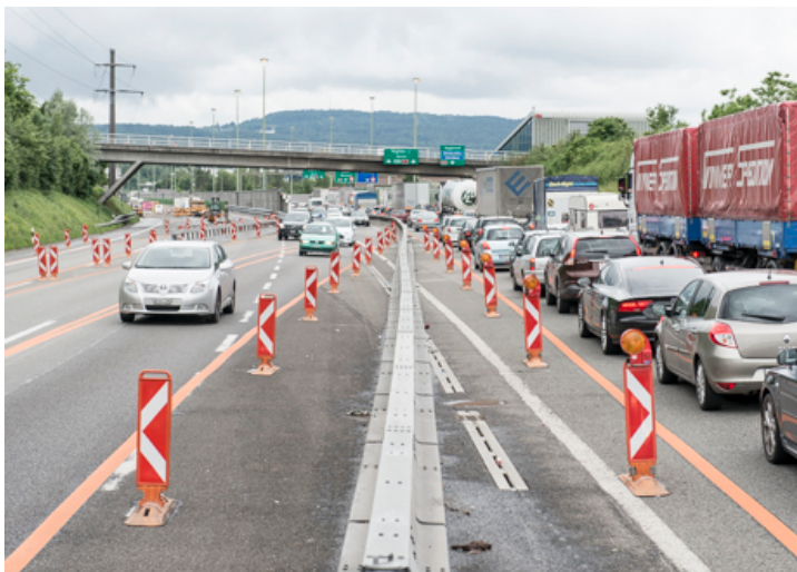
ÜBERLEITUNG AUF GEGENFAHRBAHN MIT SPURREDUKTION
