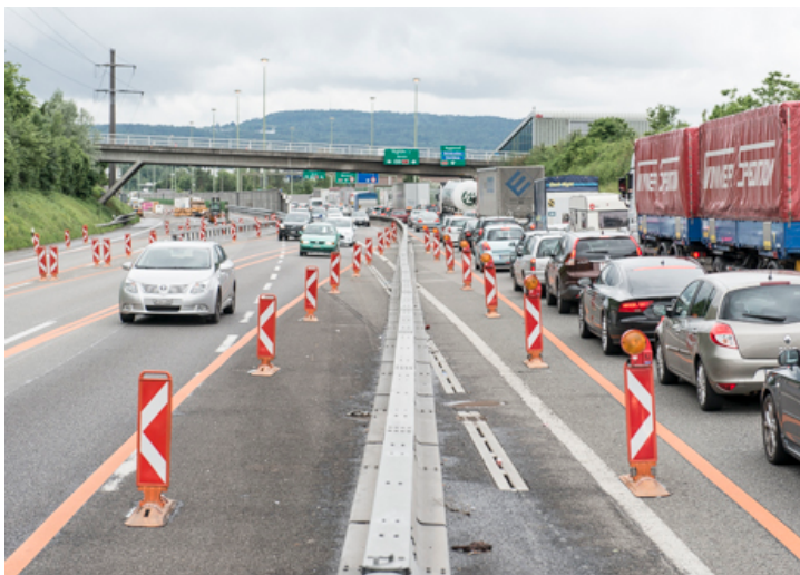
ÜBERLEITUNG AUF GEGENFAHRBAHN MIT SPURREDUKTION
