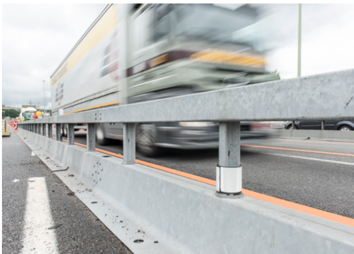
RÜCKHALTELEMENT BEI SPURVERENGUNG
