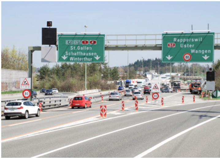
SPURÜBERLEITUNG MIT GESCHWINDIGKEITSREDUKTION
