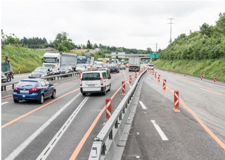
SPURÜBERLEITUNG MIT VERENGTER SPURFÜHRUNG
