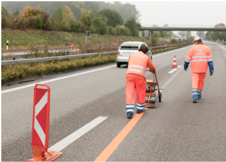
TRAVAUX DE SIGNALISATION, © OFROU
