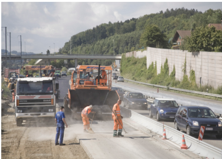
TRAVAUX AU REVÊTEMENT
