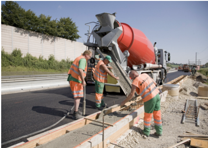
TRAVAUX DE BÉTONNAGE
