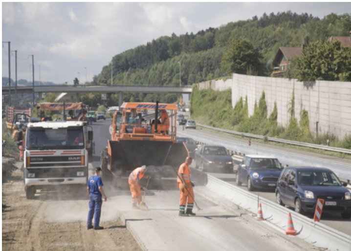
TRAVAUX AU REVÊTEMENT
