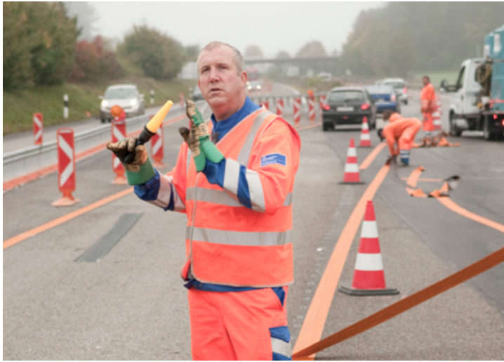
MISE EN PLACE D'UN CHANTIER EN PLEIN TRAFIC, © OFROU
