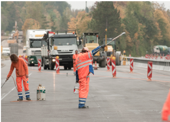
TRAVAUX DE MARQUAGE, © OFROU
