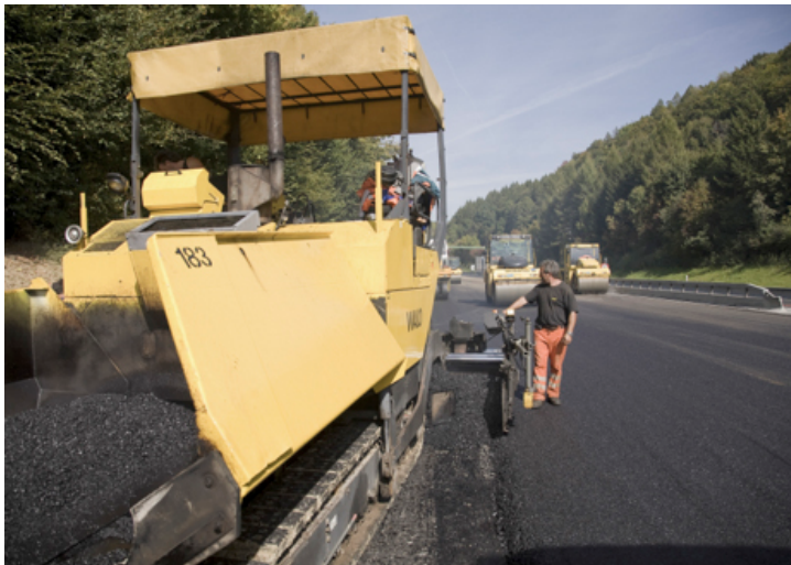
TRAVAUX AU REVÊTEMENT
