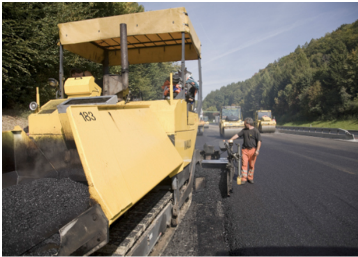
TRAVAUX AU REVÊTEMENT
