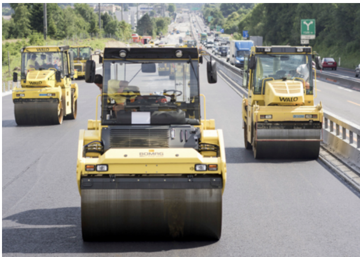
TRAVAUX DE COMPRESSION APRÈS LA POSE DU REVÊTEMENT
