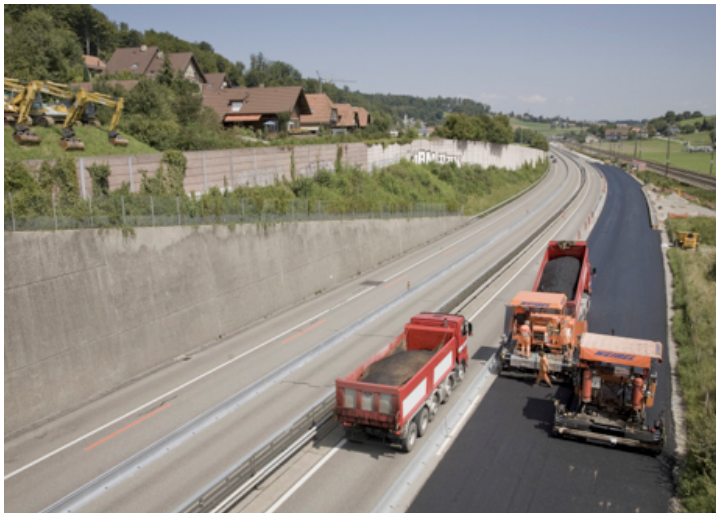
POSE DE REVÊTEMENT AVEC RÉTRÉCISSEMENT DE LA VOIE
