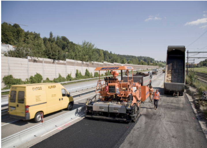
POSE DE REVÊTEMENT SUR L'AUTOROUTE
