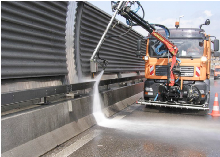
NETTOYAGE D'UNE PAROI ANTIBRUIT
