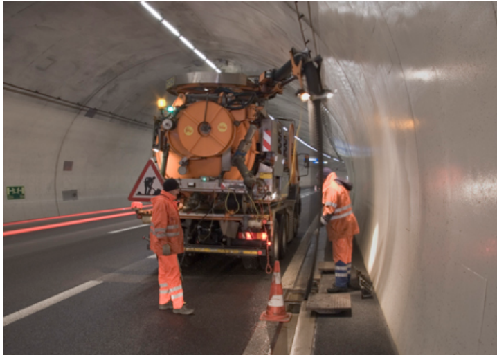
NETTOYAGE D'UN CANAL DANS UN TUNNEL
