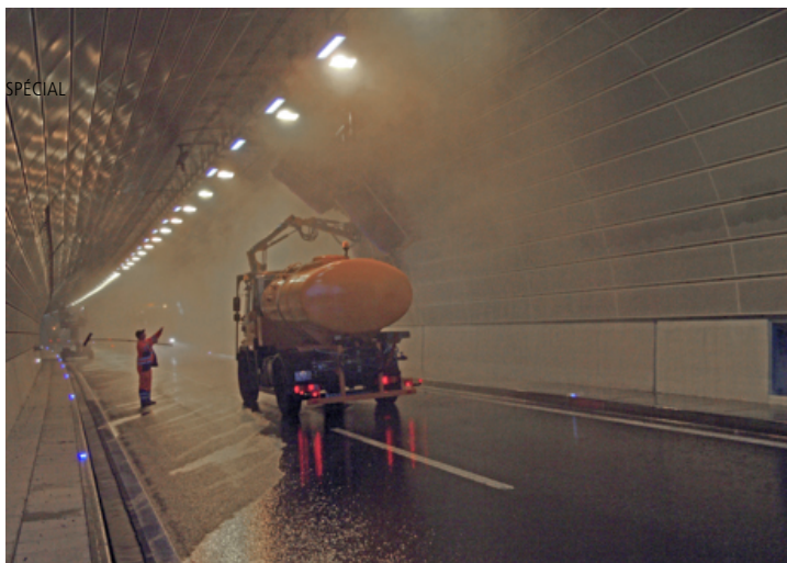
NETTOYAGE D'UN TUNNEL AU MOYEN D'UN VÉHICULE
