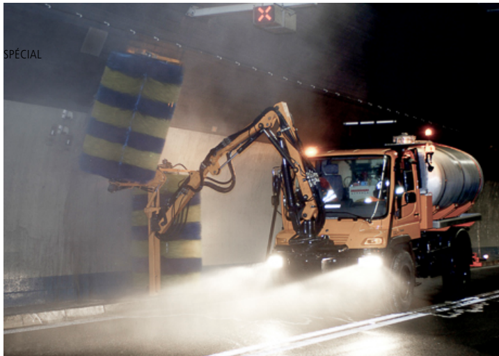
NETTOYAGE D'UN TUNNEL AU MOYEN D'UN VÉHICULE
