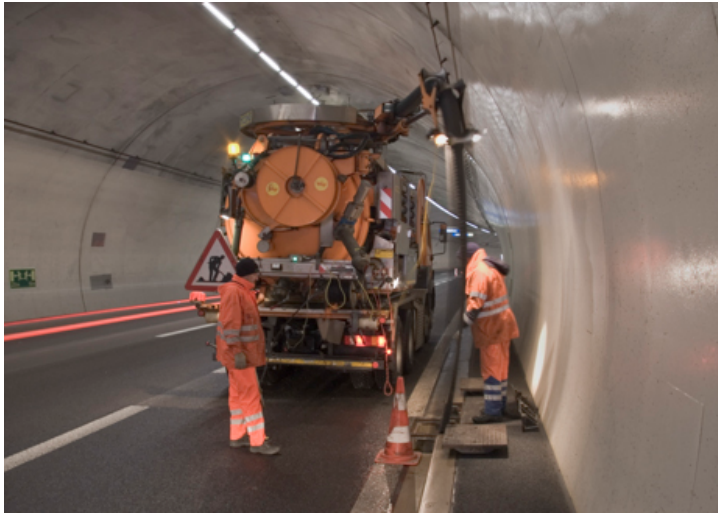
NETTOYAGE D'UN CANAL DANS UN TUNNEL
