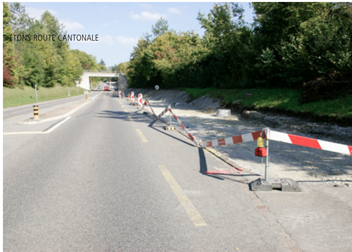
CONSTRUCTION DE PISTES CYCLABLES ET DE SENTIERS POUR
