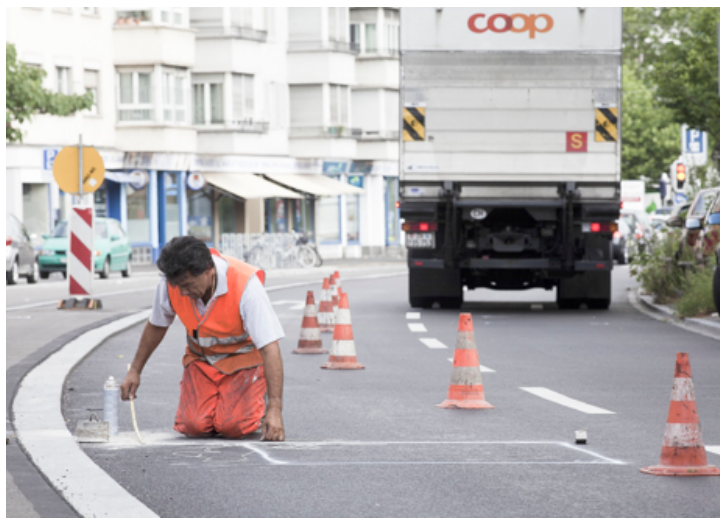
TRAVAUX DE MARQUAGE ROUTE COMMUNALE
