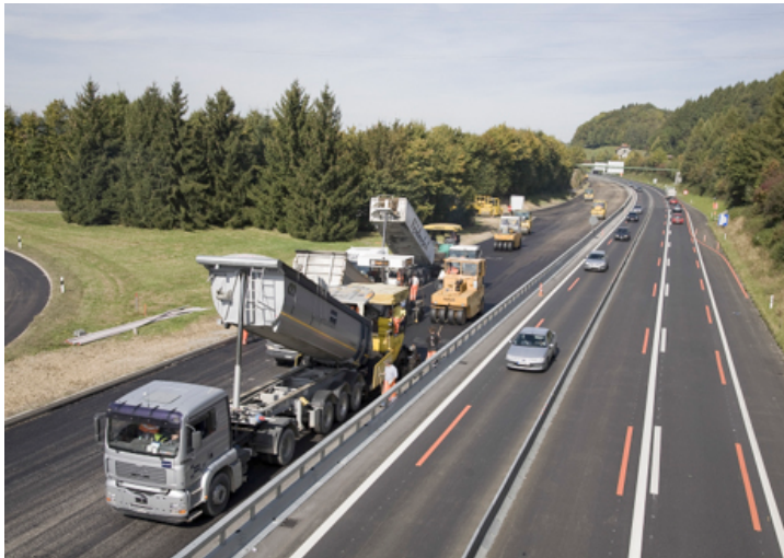
TRAVAUX DE REVÊTEMENT ROUTE NATIONALE
