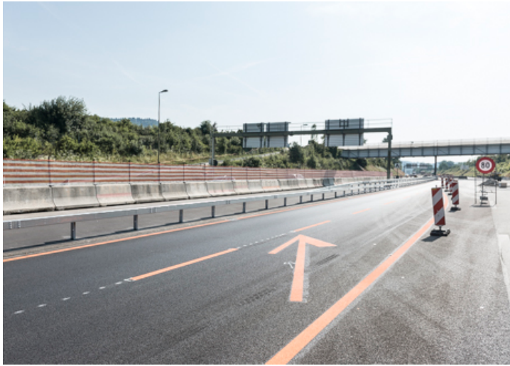
RÉTRÉCISSEMENT DE LA VOIE
