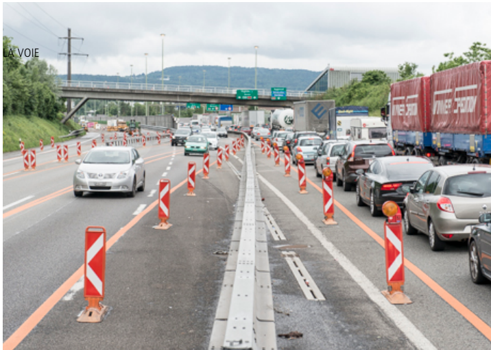
DÉVIATION SUR LA VOIE OPPOSÉE AVEC RÉTRÉCISSEMENT DE
