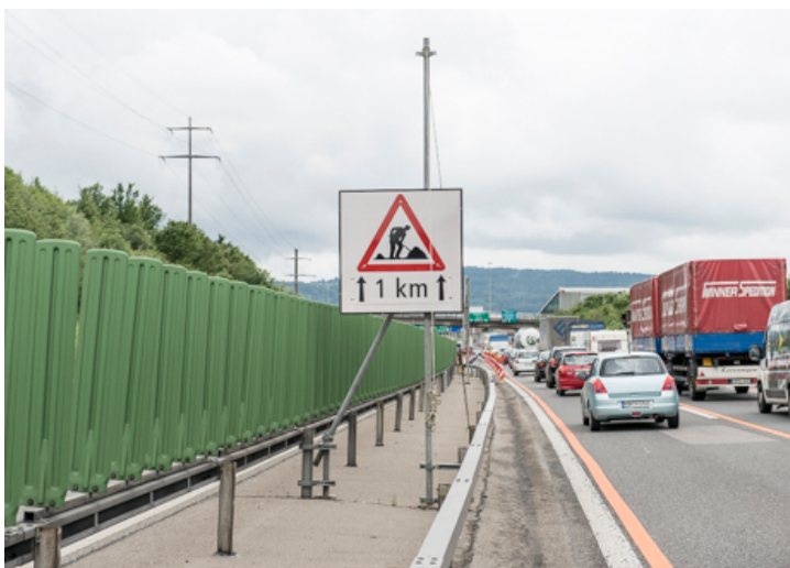
SIGNALISATION DE CHANTIER
