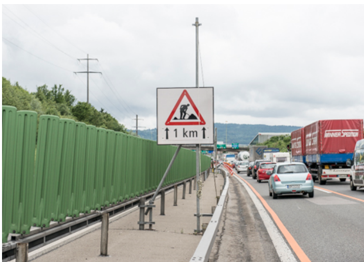
SIGNALISATION DE CHANTIER
