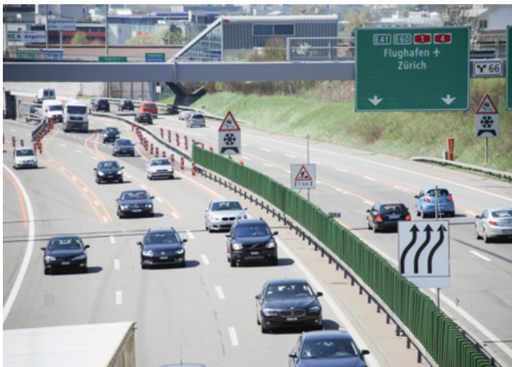
FIN DE CHANTIER
